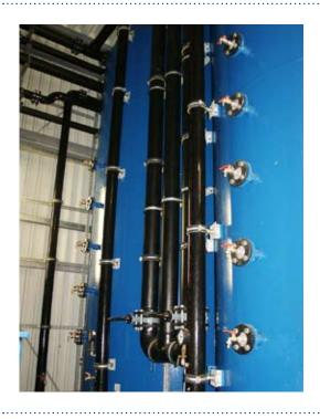
Verrohrung der Sandfilter mit automatischer Rückspülung. Die Anlage ist ausgestattet mit Prozessvisualisierung und Fernabfrage.
