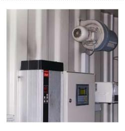
Steuerung der Anlage inkl. zusätzlicher UEG-Überwachung vor der katalytischen Oxidationsanlage
