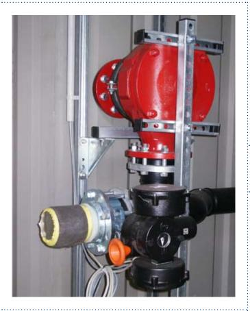
UEG-Überwachung der abgesaugten Bodenluft und Wasserabscheider in druckstoßfester Ausführung
